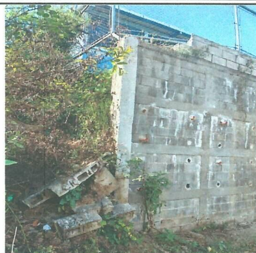
Foto 2: Mejoramiento del Cerco o muro Perimetral
