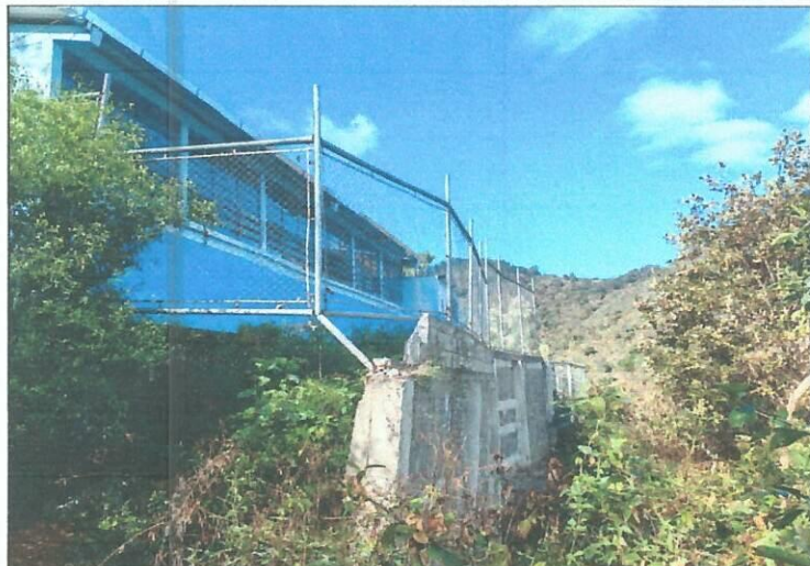
Foto 1: Mejoramiento del Cerco o muro Perimetral
