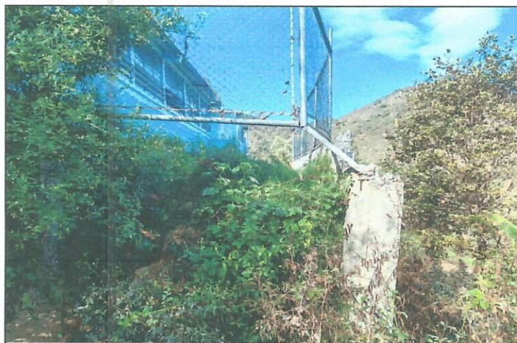
Foto 3: Mejoramiento del Cerco o muro Perimetral
